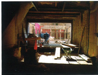
Ci-dessous, la cuisine en chantier et l'entrée réalisée.
